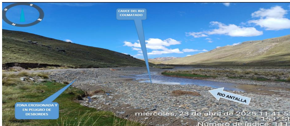
FIGURA 1 y 2: TRAMO CRÍTICO EN EL RÍO ANTALLA, EN EL SECTOR PALCA, DISTRITO DE PALCA, PROVINCIA DE LAMPA - PUNO. NOTESE, LA ACUMULACION DE MATERIAL SEDIMENTADO EN EL CAUCE, QUE REQUIERE SER ELIMINADO PARA REESTABLECER LA SECCION HIDRAULICA DE LA CAJA DEL CAUCE EN ESTE SECTOR.
