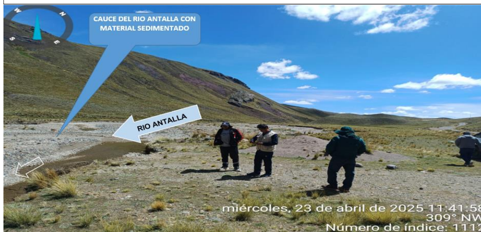
FIGURA 1 y 2: TRAMO CRÍTICO EN EL RÍO ANTALLA, EN EL SECTOR PALCA, DISTRITO DE PALCA, PROVINCIA DE LAMPA - PUNO. NOTESE, LA ACUMULACION DE MATERIAL SEDIMENTADO EN EL CAUCE, QUE REQUIERE SER ELIMINADO PARA REESTABLECER LA SECCION HIDRAULICA DE LA CAJA DEL CAUCE EN ESTE SECTOR.
